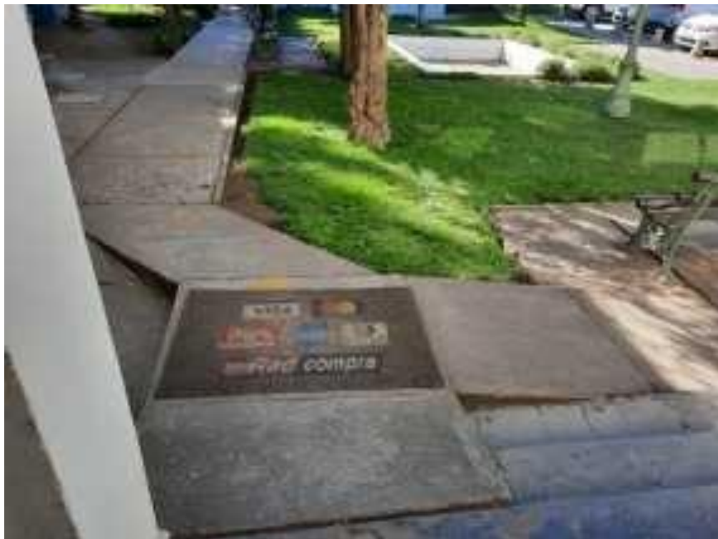
Acceso patio Edificio consistorial (rampas a demoler).
