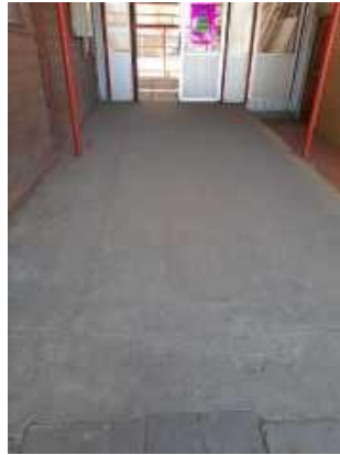
Fotografía Rampa de acceso liceo antiguo
