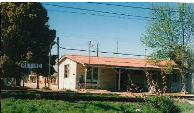
Fig. 10. Estación de Retiro
