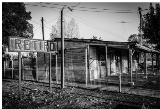
Fig. 9. Estación de Retiro
