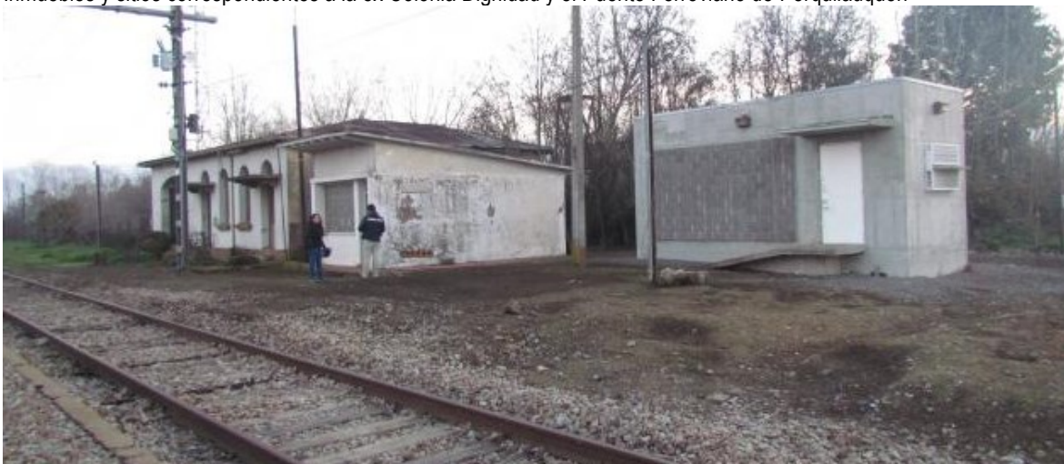
Fotografía N°2: Monumentos Históricos de la comuna de Parral: La Estación de Ferrocarril de Perquillauquén, los Inmuebles y sitios correspondientes a la ex Colonia Dignidad y el Puente Ferroviario de Perquillauquén
